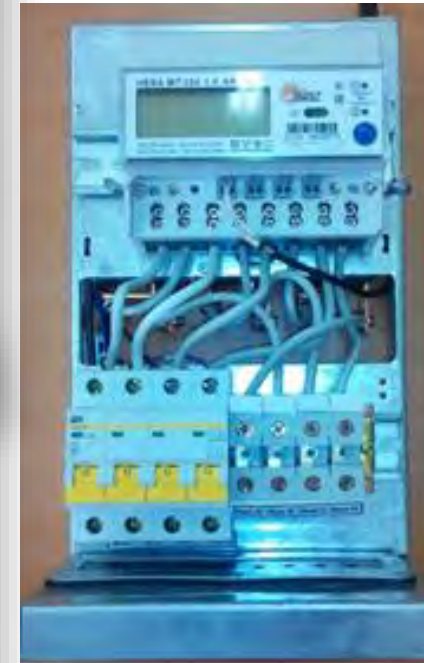
Учет электроэнергии и мониторинг в частном секторе (использование беспроводного интерфейса ZigBee)
